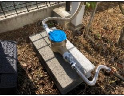
自動散水栓にサブメーターを設置し、より詳細の水使用量を把握し、節水施策につなげる
