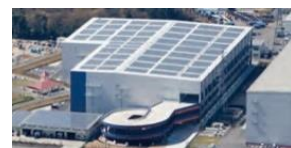
太陽光パネルの設置
