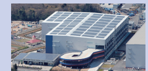
太陽光パネル
