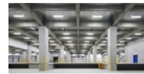
LED照明の導入
