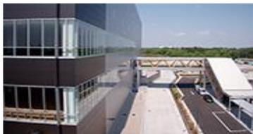
従業員が駐車場から直接エスカレーターで2階にアプローチして入館する特徴的な仕様を採用し、歩行者動線とトラック動線を分離することで安全性を確保
